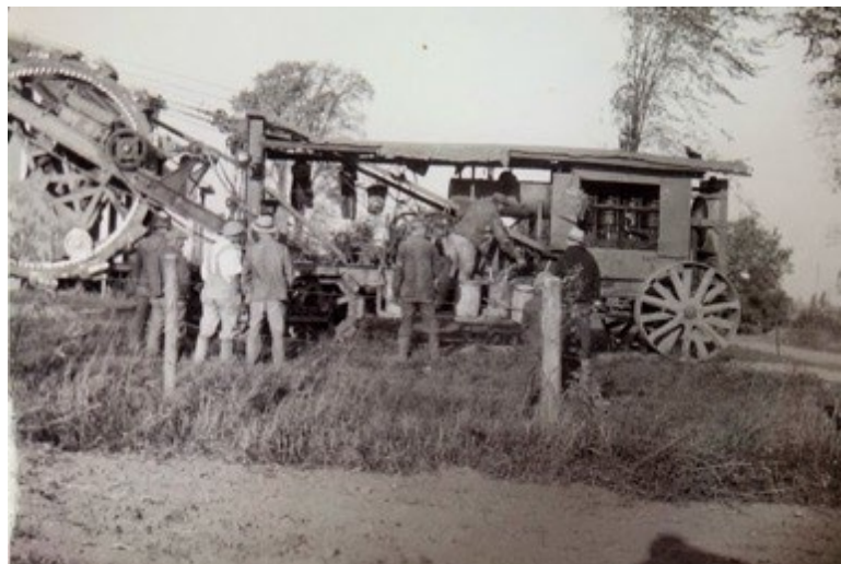
La construction de l'oléoduc Portland-Montréal à Ange-Gardien et Saint-Césaire
